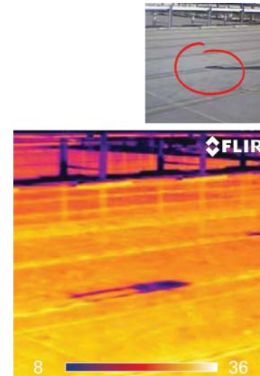
Цурење равнoг крова. Јасно уочљива зона влажне изолације омогућава ефикасну и брзу поправку. Leakage of flat roof construction. Clearly visible zone of wet insulation enables efficient and fast repair.
